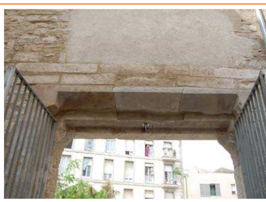
Reompliment del forat de la part posterior de la llinda
