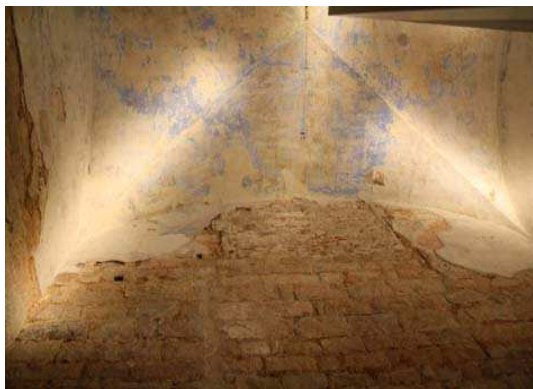
Vista parcial de la volta i de la paret sud de la capella 1 de Sant Rafael. Es veu la volta de finals del seg. XVI i a la paret sud, la forma de la finestra tapiada, després de la intervenció.
