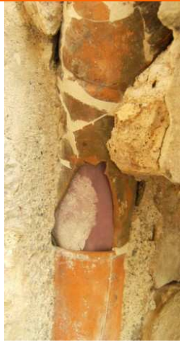
Reintegració de la segona peça del conducte cilíndric
