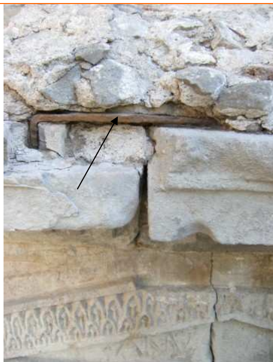
Grapa de ferro situada a la cornisa, costat esquerre
