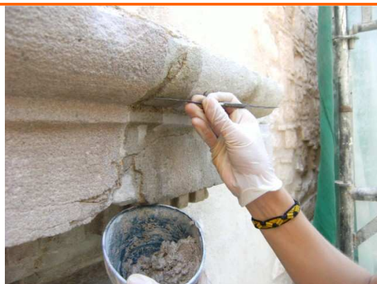
Aplicació del morter a base de calç hidràulica i sorra en un junt
