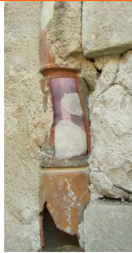
Reintegració de les dues últimes peces del conducte cilíndric
