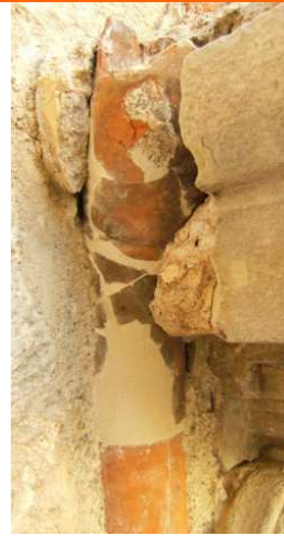
Reintegració de la segona peça del conducte cilíndric
