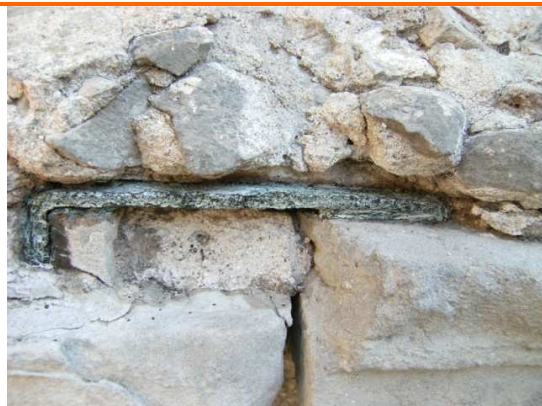
Aplicació del producte inhibidor de la corrosió
