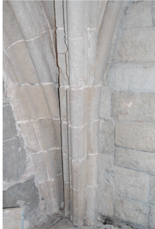
Aspecte de la base del nervi de nord-oest de la capella 5 després de l'aplicació de veladures damunt del ciment portland
