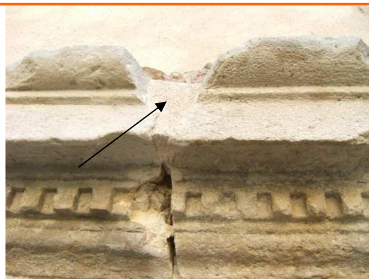
Reintegració en curs d'una part mancanta amb morter de calç hidràulica i sorra
