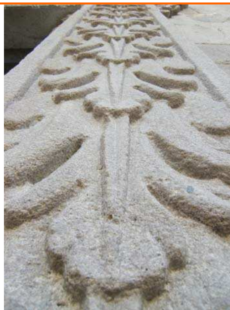
Detall del pilar de l'esquerra després de la restauració
