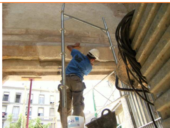
Aplicació del morter al forat de la part posterior de la llinda
