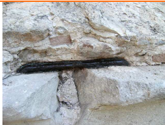
Estat de la grapa després de l'aplicació del producte inhibidor
