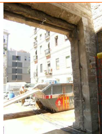
Crosta negra afectant la part posterior del portal
