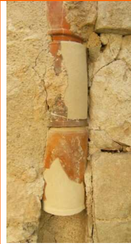
Reintegració de les dues últimes peces del conducte cilíndric
