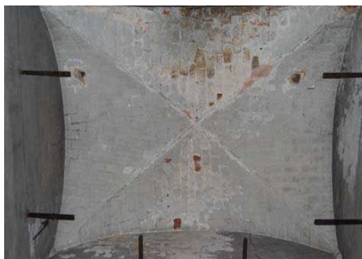
Volta de la capella 2 de Sant Sever abans de la restauració. Aquesta volta també es remunta suposadament al final del seg. XVI
