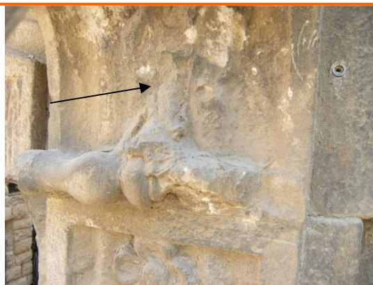
Pèrdua de la torre que decora el capitell de la pilastra dreta
